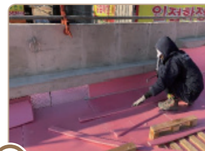
5 파라펫구간 진공단열재 시공 및 보양
