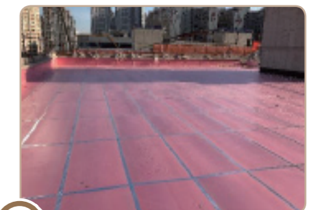
6 조인트 테이프 시공
